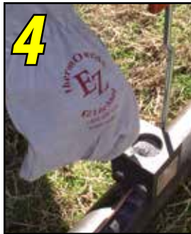
4 Pour weld metal into mold.
